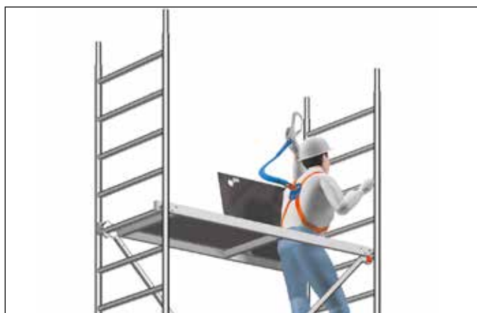
Fig. 1: Enganche del EPI durante el ascenso a un nivel sin asegurar
