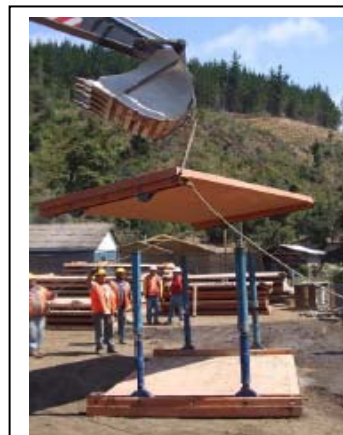
7.- Trasladar este panel (con los apoyos articulados) con la excavadora, y posicionarlo sobre el panel con los distanciadores y apoyos articulados.
