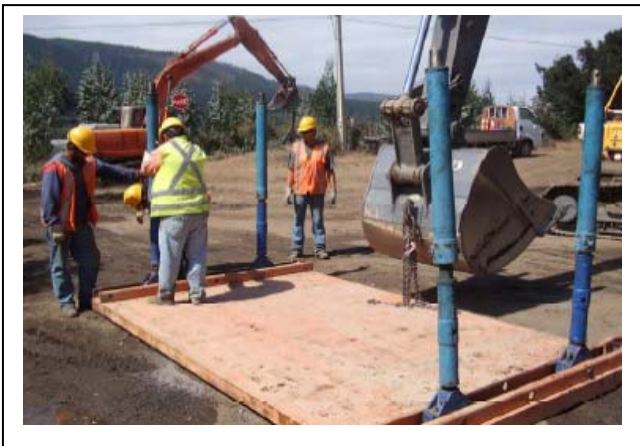
5.- Montaje de los distanciadores con apoyos en las guías de los Paneles.
