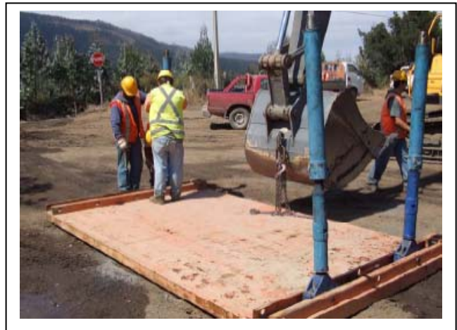
5.- Montaje de los distanciadores con apoyos en las guías de los Paneles.
