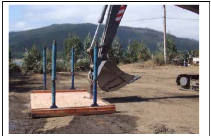
5.- Montaje de los distanciadores con apoyos en las guías de los Paneles.
