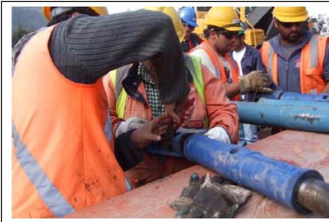
2.- Armado de Husillos o distanciadores con el apoyo articulado
