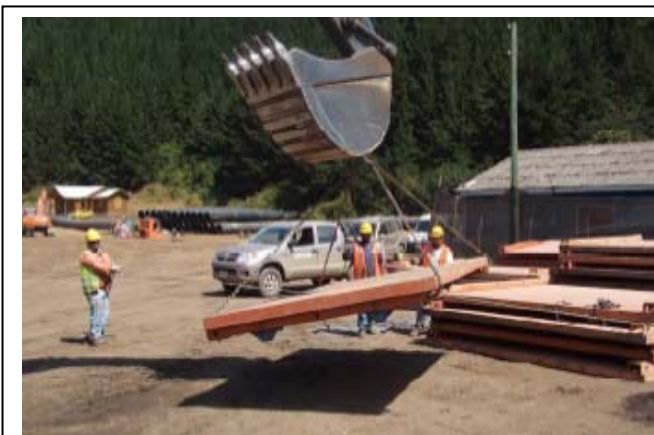
7.- Trasladar este panel (con los apoyos articulados) con la excavadora, y posicionarlo sobre el panel con los distanciadores y apoyos articulados.
