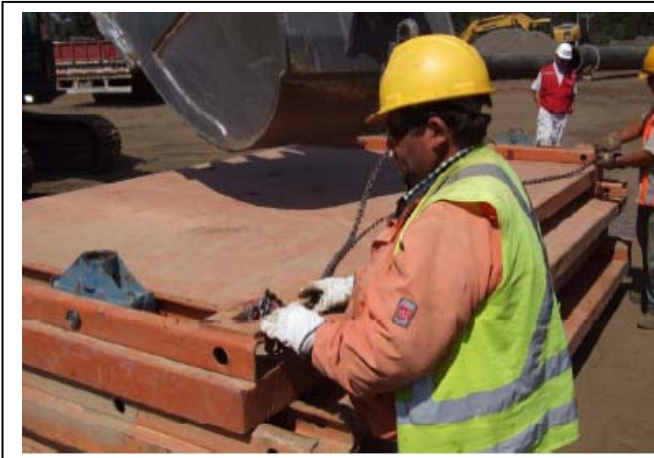
6.- Se monta en otro panel, solo los apoyos articulados en las mismas posiciones de espaciado de la guía.
