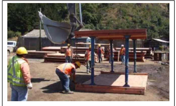
10.- Con una cadena de 4 puntas o similar se debe colocar en posición el cajón ya armado.
