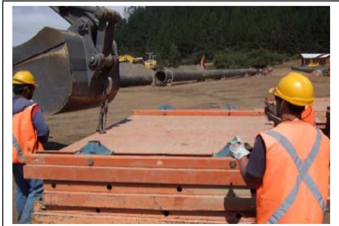
6.- Se monta en otro panel, solo los apoyos articulados en las mismas posiciones de espaciado de la guía.
