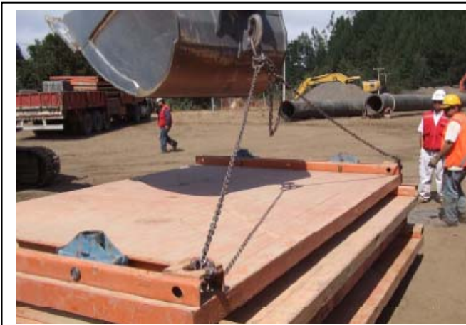
7.- Trasladar este panel (con los apoyos articulados) con la excavadora, y posicionarlo sobre el panel con los distanciadores y apoyos articulados.
