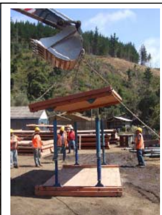
7.- Trasladar este panel (con los apoyos articulados) con la excavadora, y posicionarlo sobre el panel con los distanciadores y apoyos articulados.
