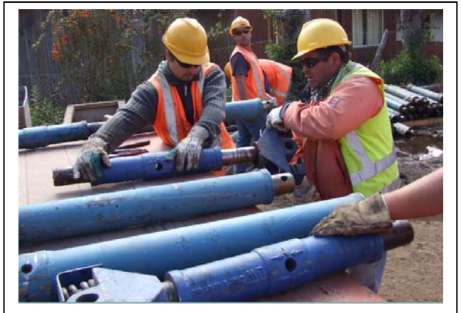
2.- Armado de Husillos o distanciadores con el apoyo articulado
