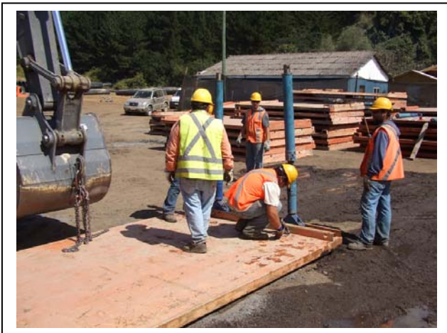
5.- Montaje de los distanciadores con apoyos en las guías de los Paneles.
