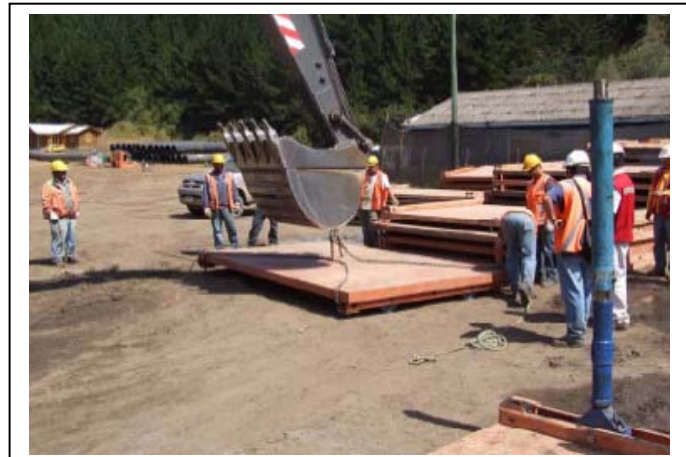
7.- Trasladar este panel (con los apoyos articulados) con la excavadora, y posicionarlo sobre el panel con los distanciadores y apoyos articulados.
