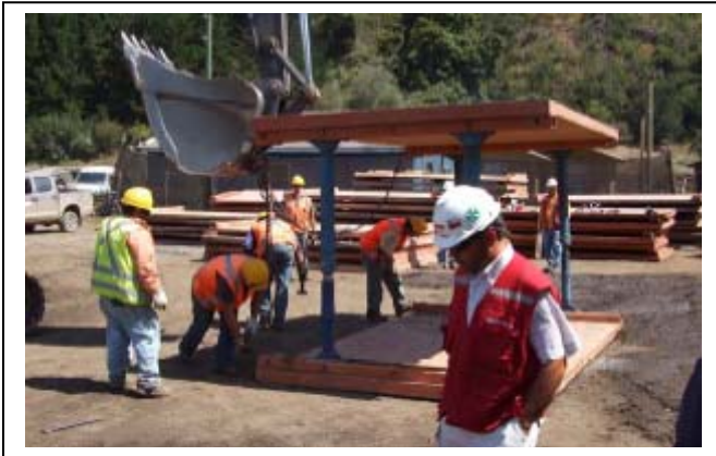
10.- Con una cadena de 4 puntas o similar se debe colocar en posición el cajón ya armado.
