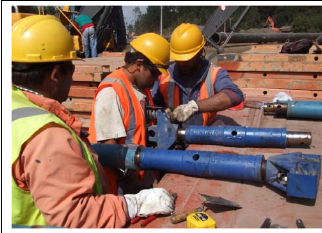
4.- Montaje de los distanciadores con apoyos en las guías de los Paneles. Bulón de 43mm fijación para el apoyo articulado
