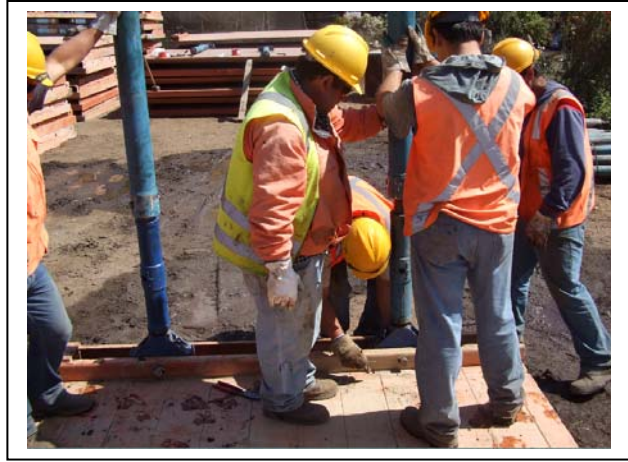
4.- Montaje de los distanciadores con apoyos en las guías de los Paneles. Bulón de 43mm fijación para el apoyo articulado
