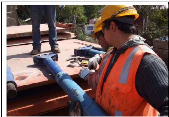
3.- Colocar Bulón de 20mm con chavetas.
