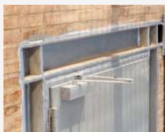
INSTAL·LACIÓ BANDA FRONTISSES
