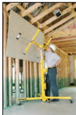
La palanca de conducción permite una ubicación óptima.
