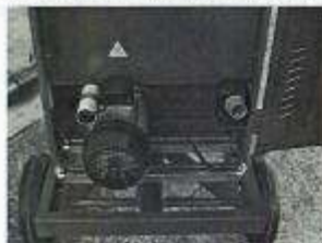
Fig. 2.2. Montaje del motor eléctrico.
