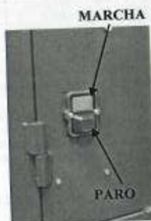
Fig. 4.1. Interruptores marcha y paro
