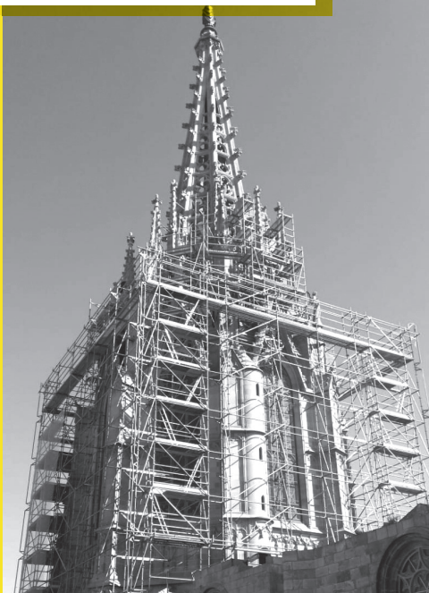
Restauración Patrimonio histórico Catedral de Barcelona
