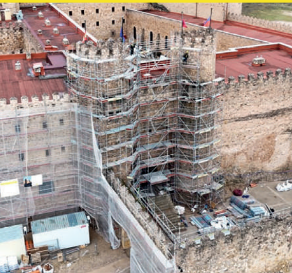
Restauració Patrimoni històric Parador de Sigüenza
