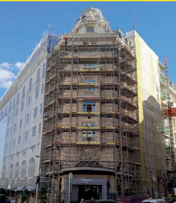
Rehabilitació Hotel Palace Madrid
