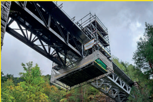
Manteniment Pont ferroviari Jaca
